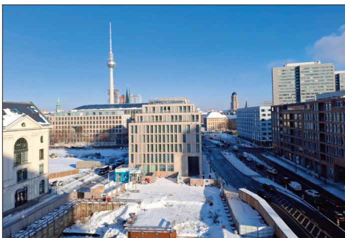
Aussicht von der Dachterrasse vom Petrimuseum auf die Baustelle vom House of One.
