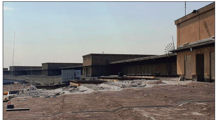
Die Dachsanierung geht weiter und soll voraussichtlich im Frühjahr 2027 beendet werden.
